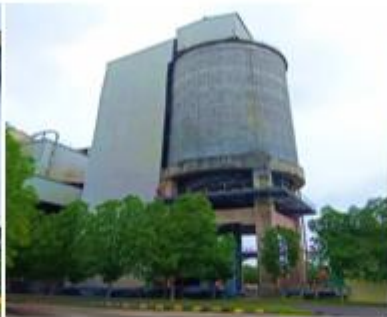
Fly ash Silo
